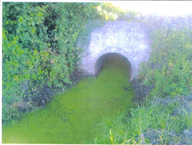
Photo n°5 : Passage busé diamètre 1 000 du ruisseau de la Maugerie
